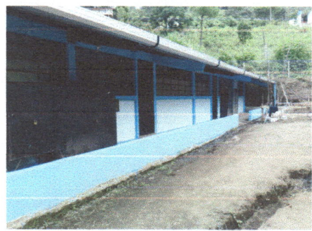
Foto 6: el muro de 0.80 con remate fue colocado en contorno del pasillo
