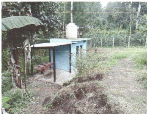
Foto 9: La base de concreto de 0.05 mts de grosor en el área de pila y baños fue cambiado en su totalidad
