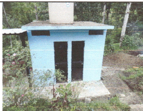
Foto 4: Las dos puertas de metal de 0.8*2.10 en los sanitarios fue cambiado en su totalidad
