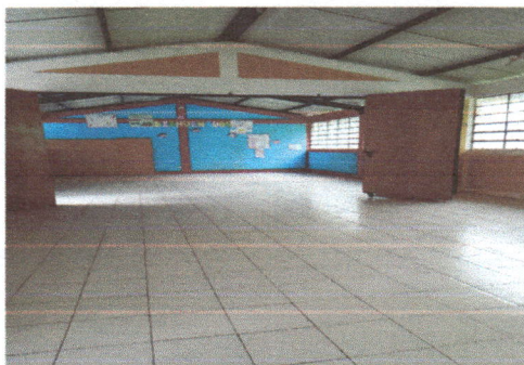
Foto 5: El piso ceramico samboro fue cambiado en su totalidad en las areas de dos aulas y direccion en formato de 0.31*0.31 mts
