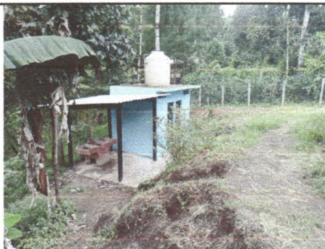
Foto 3: La estructura de soporte portante de tubo HG de 4*4 en el area de pila fue cambiado en su totalidad
