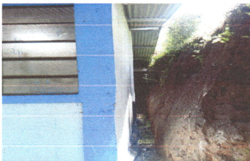
Foto 11: El mantenimiento de muro en aula No. 1 con excavacion, lavado, alisado, impermeabilizado y sellado fue reparado en totalidad
