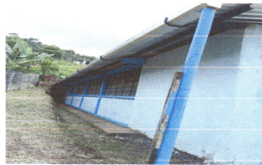
Foto 8: Puesta de canal de lamina con respectivo pescante y dos bajadas de agua fluvial en el área de atrás fue colocado en totalidad
