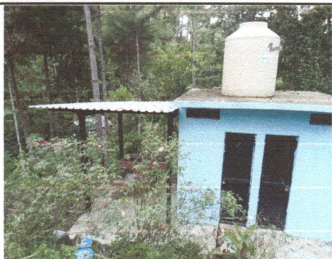
Foto 1: La cubierta de lamina troquelada calibre 26 fue colocada en totalidad en las areas de pila y direccion
